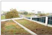
Il verde estensivo con sedum sul tetto di un edificio del complesso Galleria Naviglio.
